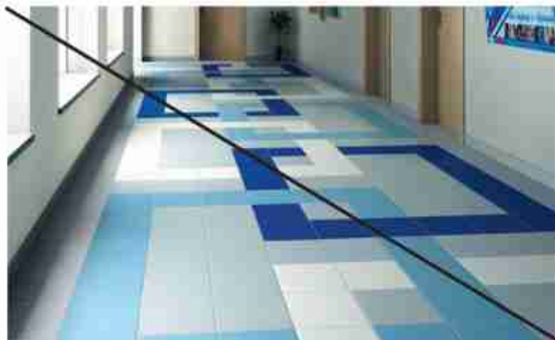
Плохо Цветные вставки из плитки
